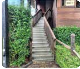
16.2: Escalier menant au quai d'embarquement
