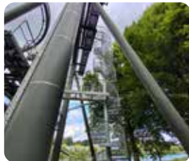
23.5: Escalier en colimaçon
