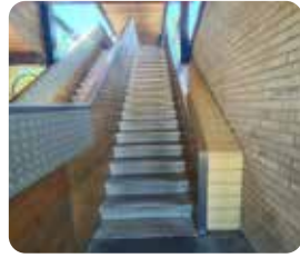
35.2: Escalier menant à la plate-forme d'embarquement
