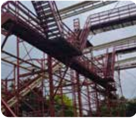
32.4: Passerelle droite au-dessus du sol
